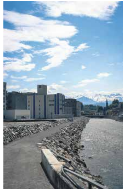
Die Wärmeverbund Seetalplatz AG versorgt in Zukunft die Gebäude der Viscosistadt und die Areale rundherum mit nachhaltig erzeugter Wärme und Kälte – 2020 geht es los.
